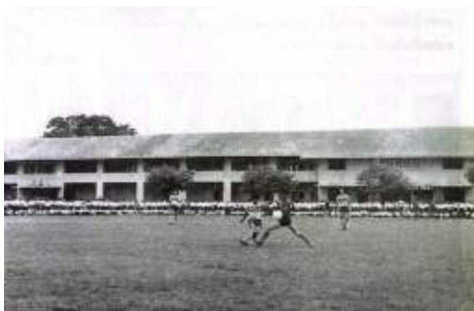
ตึกเรียน ต.ม.ธ.ก. ก่อนถูกรื้อเพื่อสร้างตึกคณะพาณิชยศาสตร์และการบัญชี
